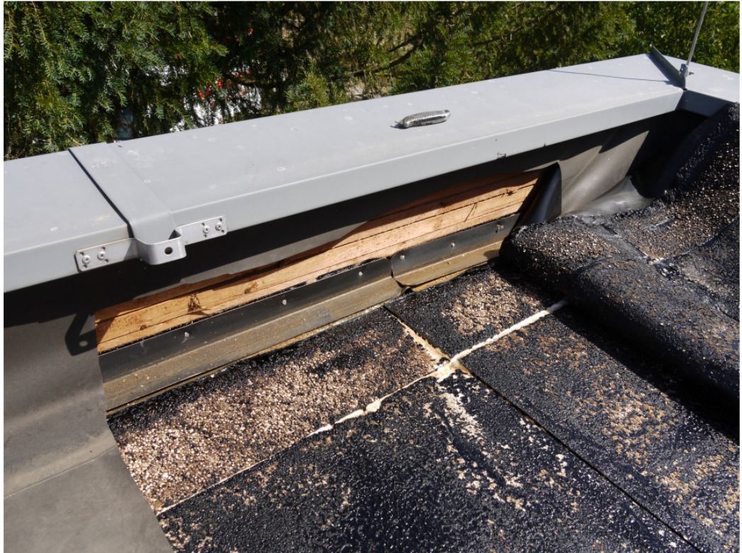
Attika-Anschluss der Abdichtung
