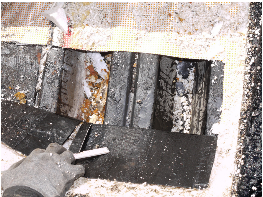
Korrodierte Zinkschicht
