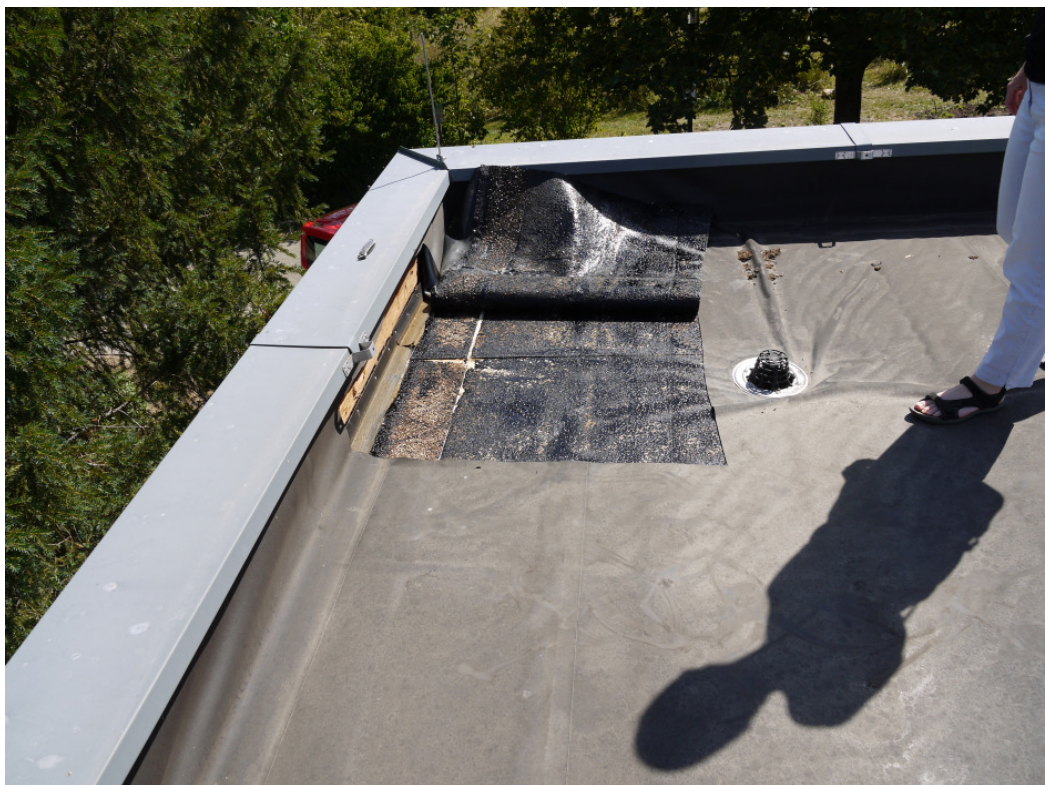
Prüfstelle 1, Abdichtung geöffnet
