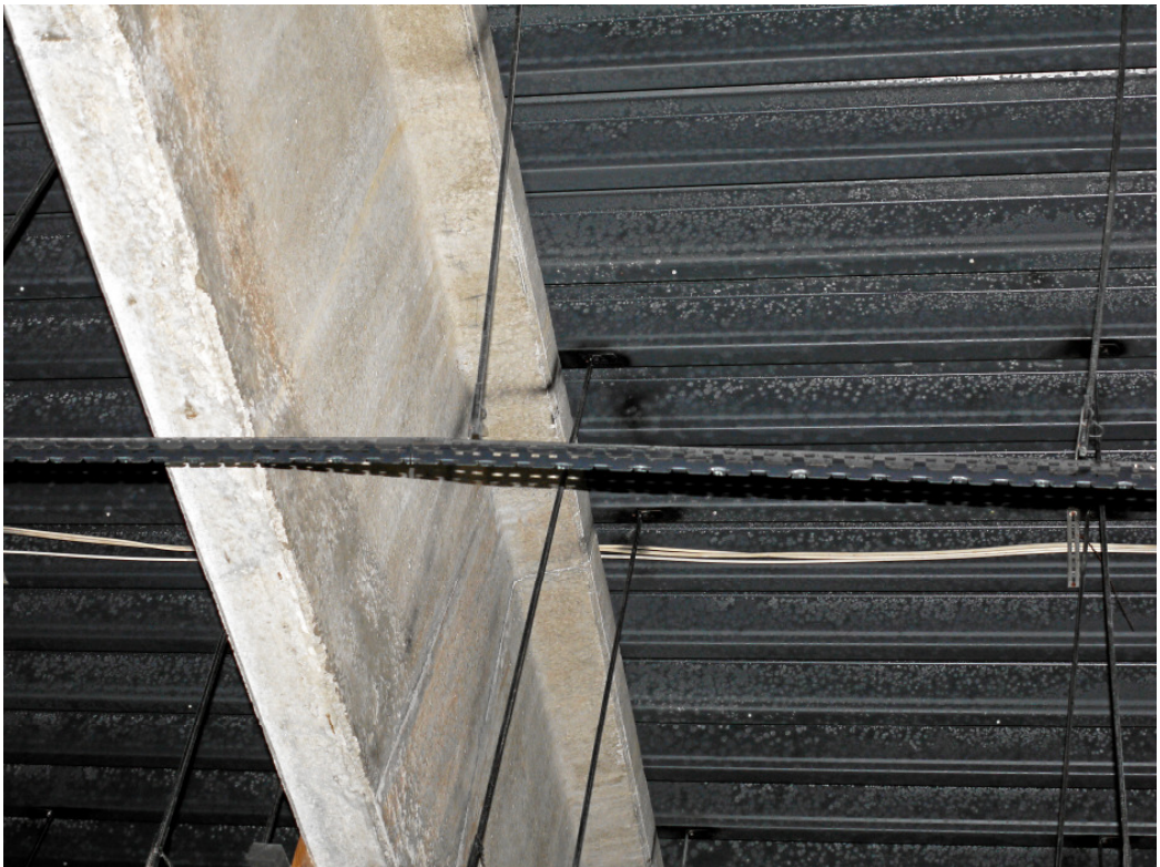
Fleckbildung in der Beschichtung
