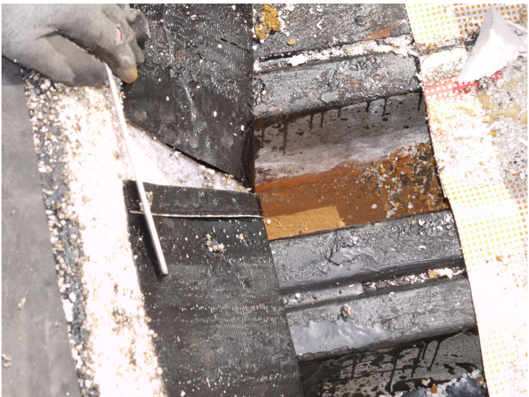
Korrosion Trapezprofil
