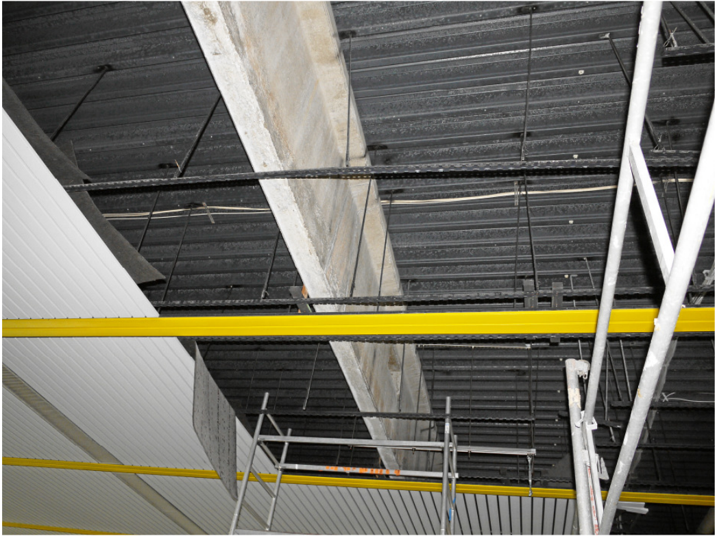
Betonbinder und Stahltrapezblechschale
