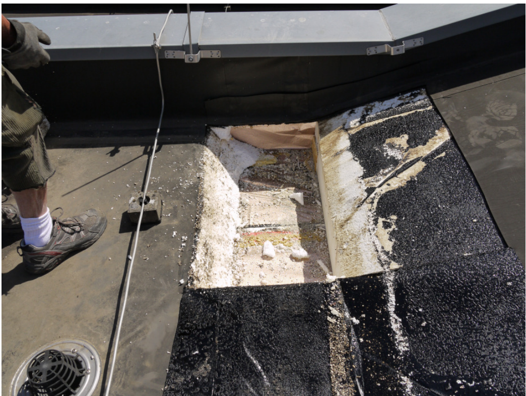
Dämmschicht entfernt
