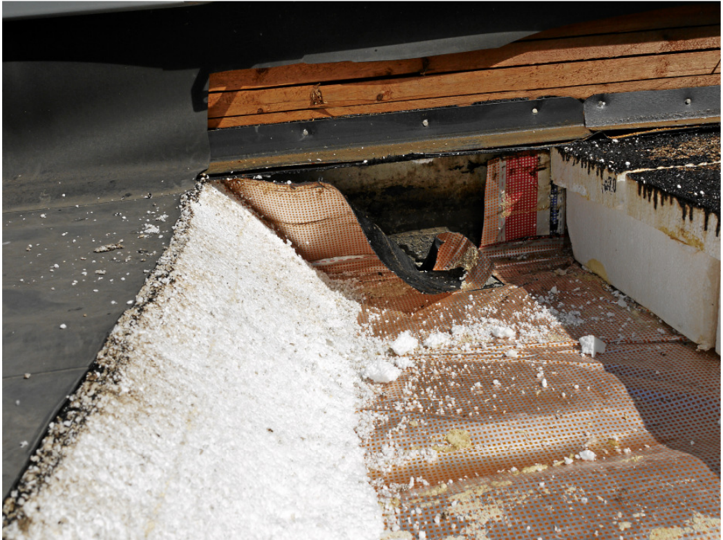
Luftoffener Attikaanschluss der Sperrfolie 13
