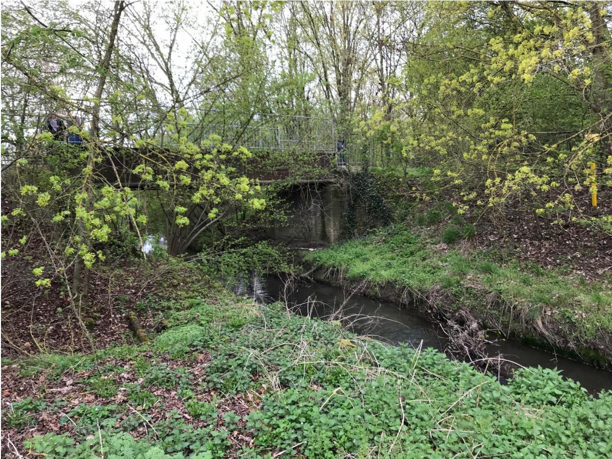
Abbildung 31: Selzbrücke ehemalige Bahntrasse
