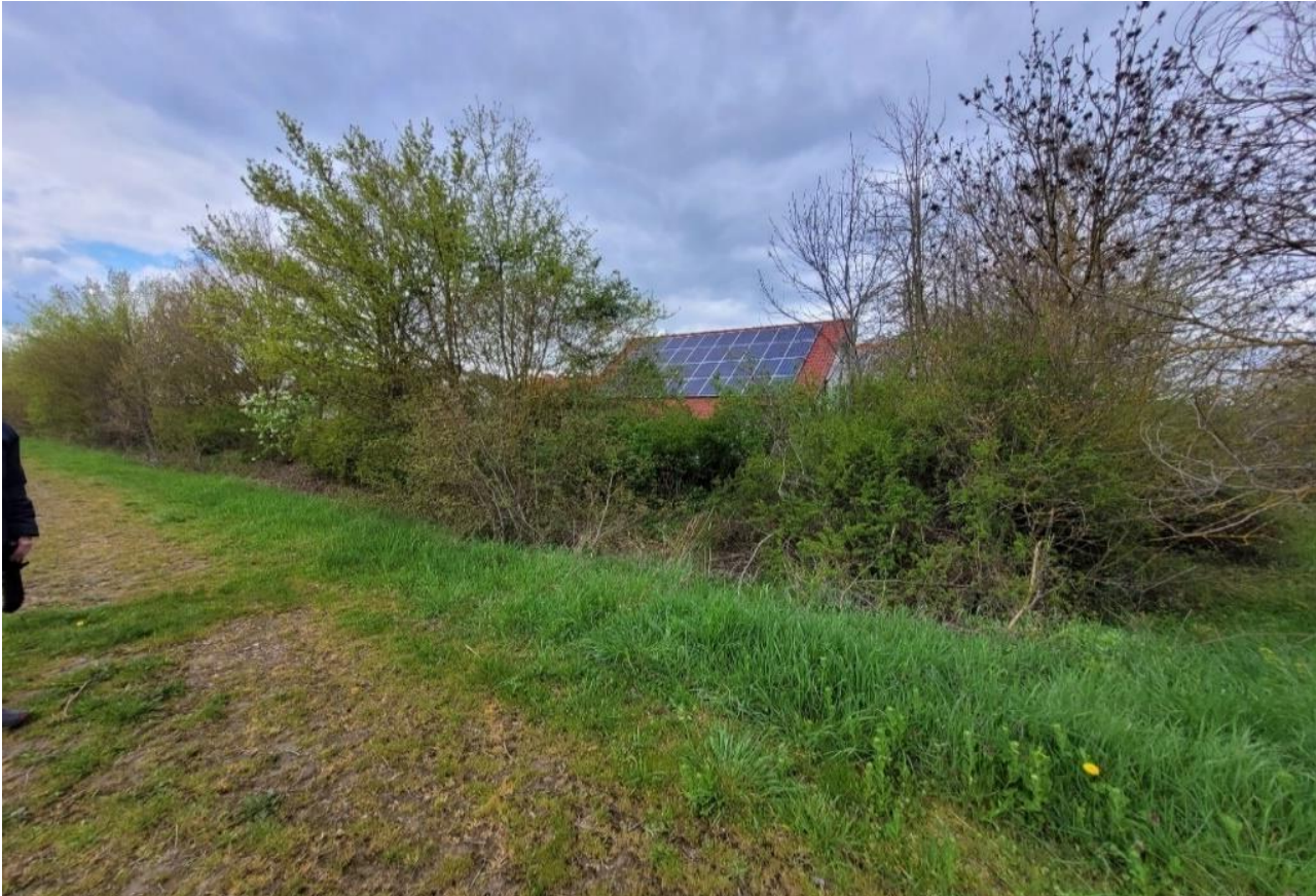
Abbildung 5: Entwässerungsgraben und Verwallung
