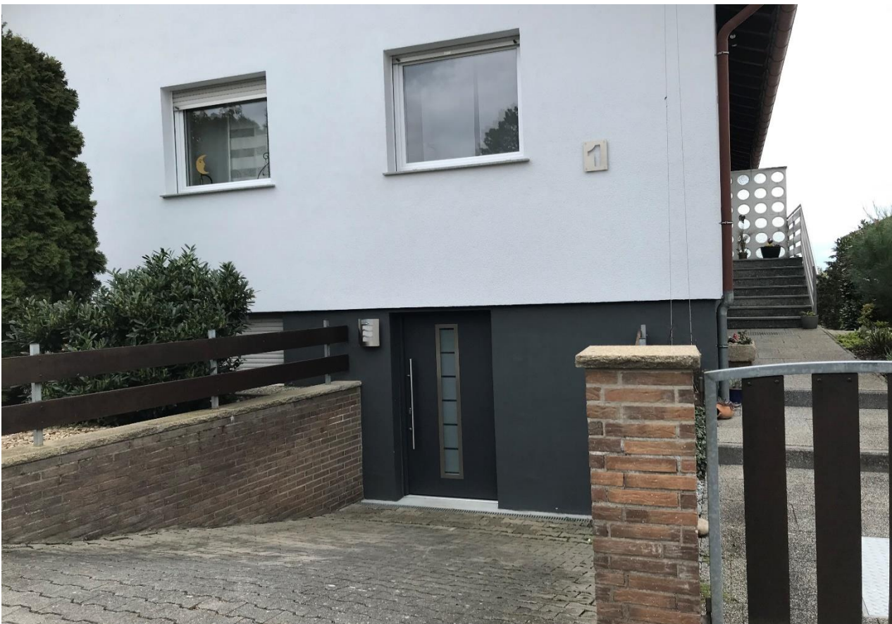
Abbildung 18: Gefährdeter tiefliegender Eingang im Sonnenweg
