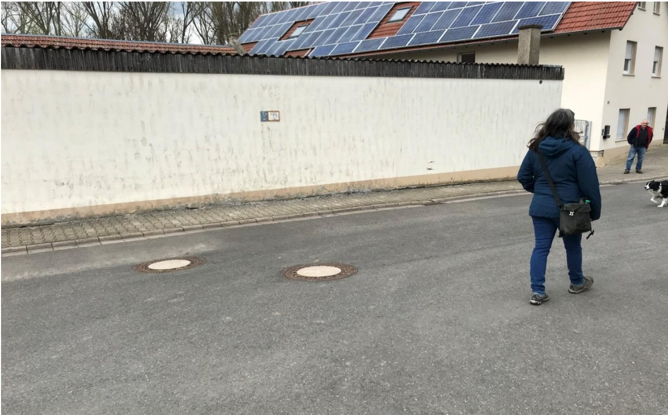
Abbildung 20: Kanaldeckel Kreuzung Sonnenweg - Mühlweg
