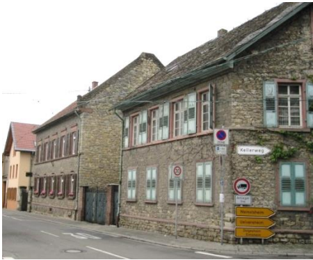
Sichtmauerwerk aus gelben Kalksandstein
