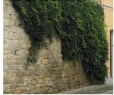
Mauer aus Naturstein
