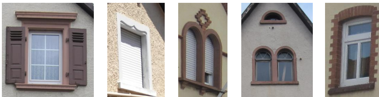
Vielfältigkeit der Fenstergewände
