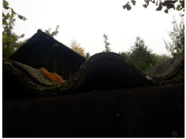
Abb. 12: Geräteschuppen, Eterniteindeckung, Quartiermöglichkeit für Fledermäuse
