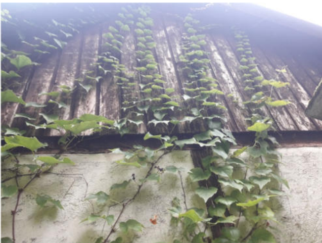
Abb. 9: Gartenhäuschen, nicht einsehbarer Dachspeicherraum
