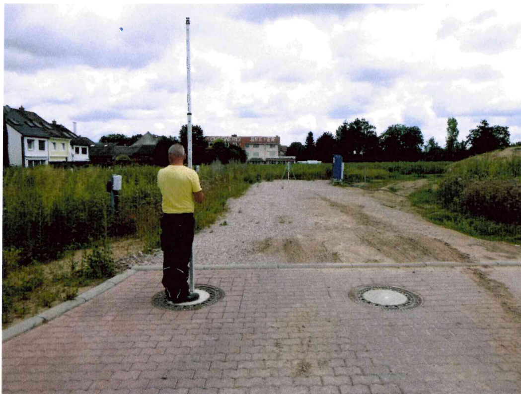
Bild 6: Höhenbezugspunkt (HP), Kanaldeckel 050811R (130,17 mNN)
