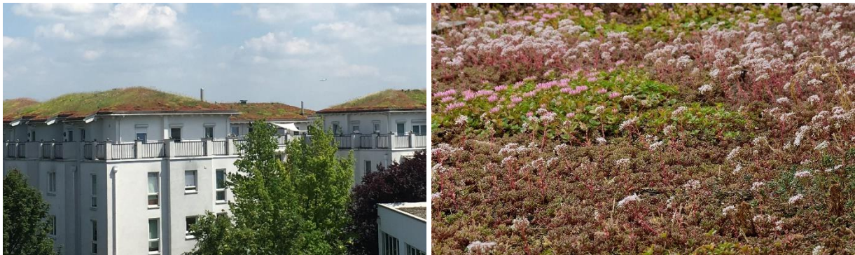
Abbildung 10: Beispiel einer Dachbegrünung (Wohngebiet Wiesbaden Erbenheim und Garagenbegrünung Nackenheim) (Bildquelle: © J. Tauchert 2015/2016)
