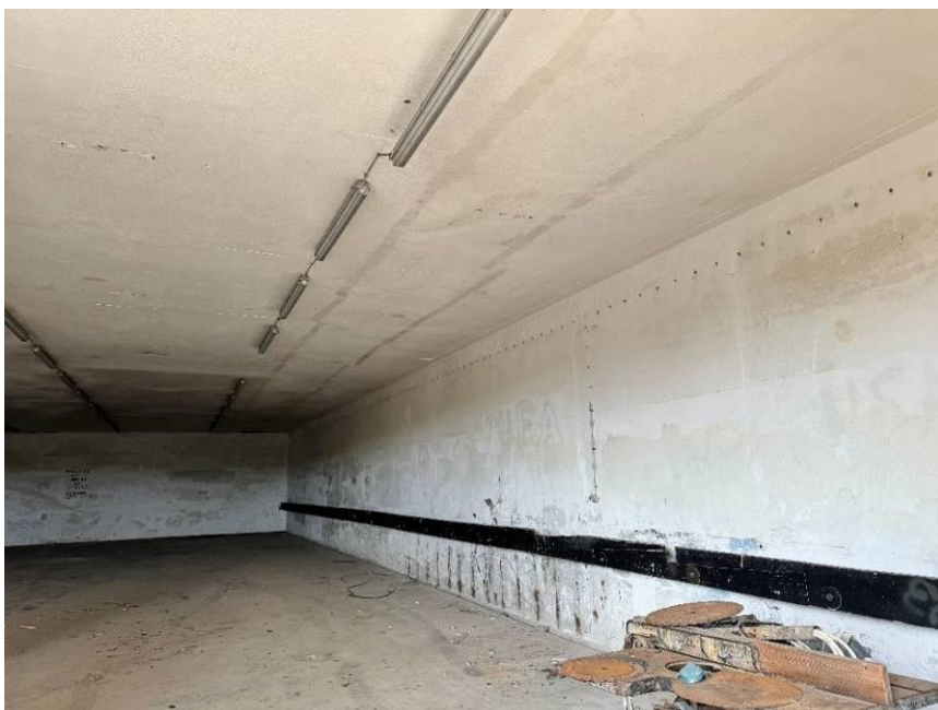
Abb. 16: Innenansicht des südwestlichen Bunkerbauwerkes ohne Fledermaus (März 2024)
