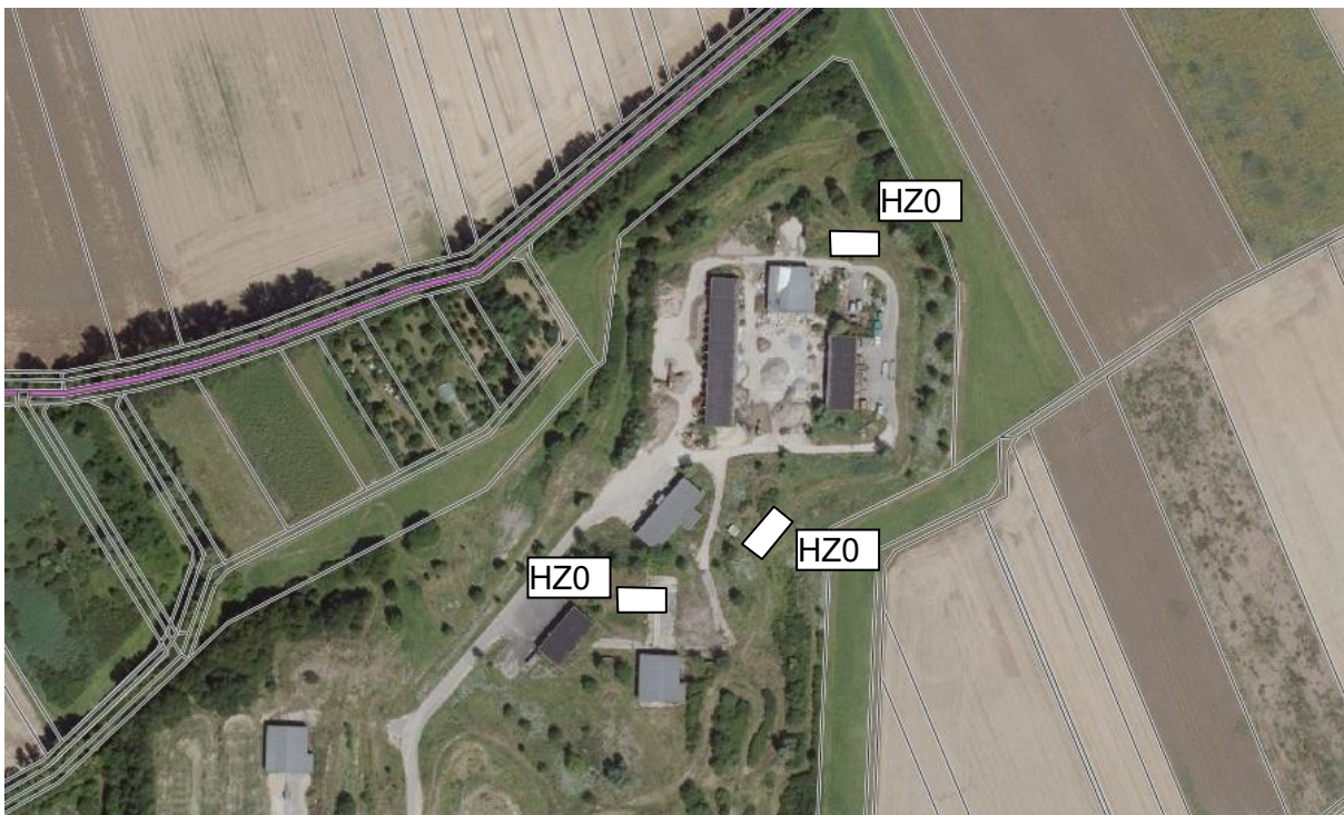
Abb. 15: Lage der als HZ0 erfassten Bunkerbauwerke im nordöstlichen Bereich des Plangebietes (LA-NIS 2025, verändert)
