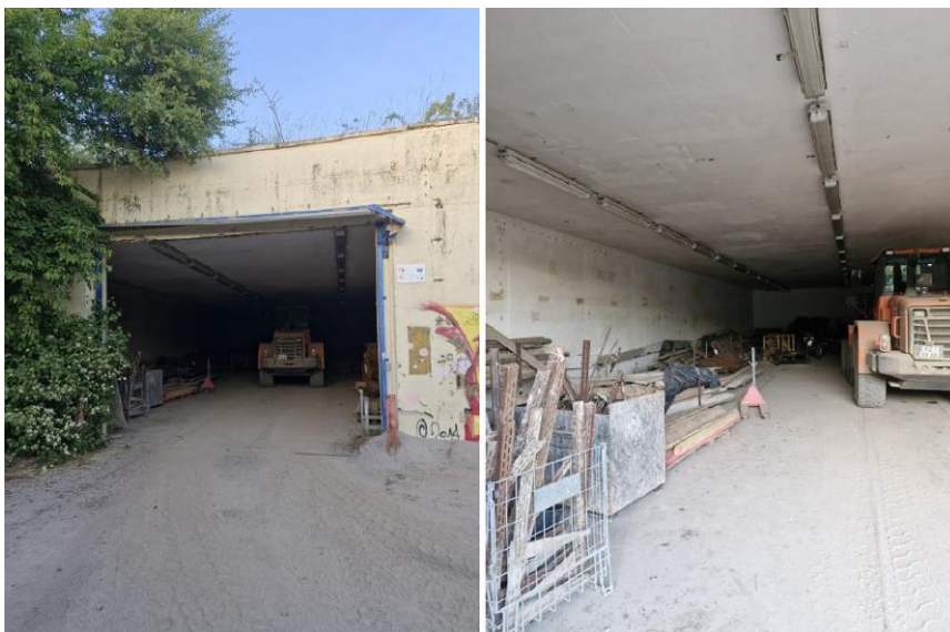
Abb. 17: Ansicht des nördlichen Bunkerbauwerkes ohne Fledermausspuren (Mai 2024)
