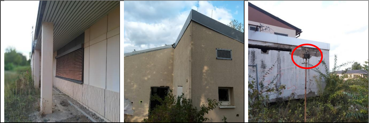
Abb. 19: potenzielle Spaltenquartiere an Gebäuden im Untersuchungsgebiet, stationierter Batcorder vor einem Gebäude (rechtes Bild, roter Kreis)
