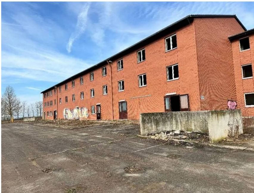
Abb. 33: Ehemalige Mannschaftsunterkünfte im Westteil (März 2024)
