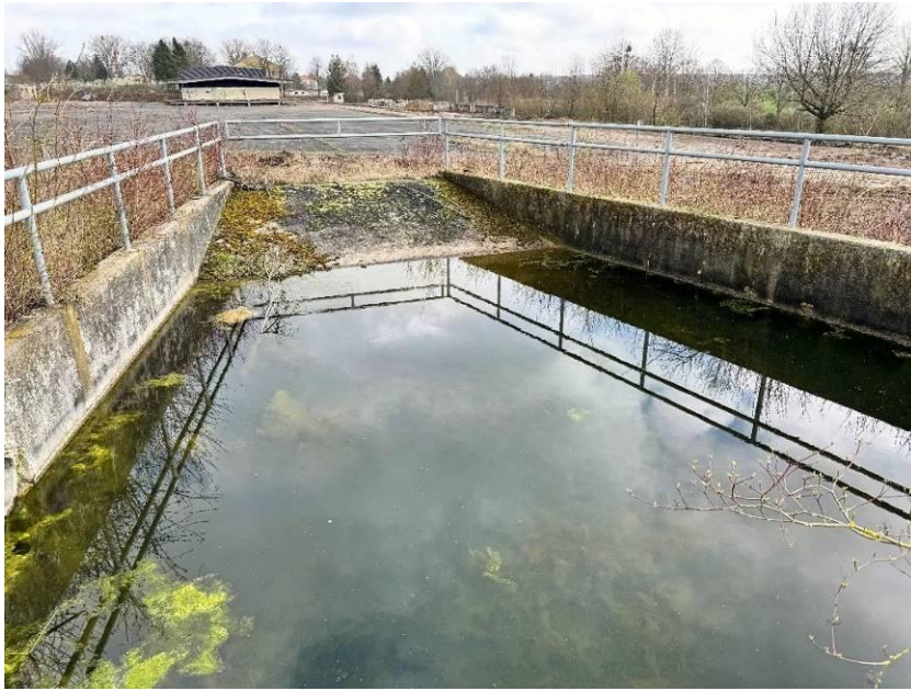
Abb. 27: Technisch ausgebautes Kleingewässer im Westteil der Liegenschaft (März 2024)
