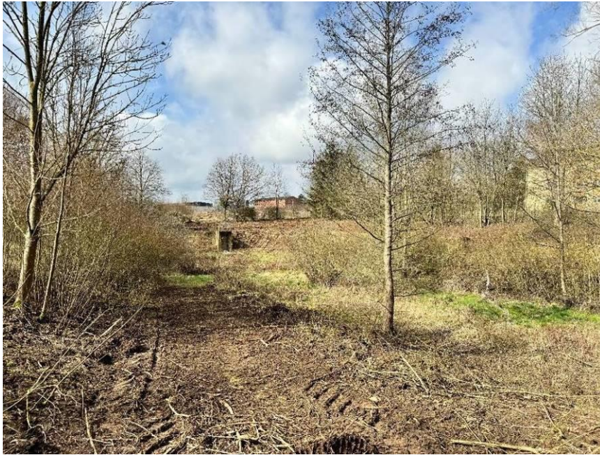
Abb. 24: Rückhaltebecken nördlich der B 420 (März 2024)
