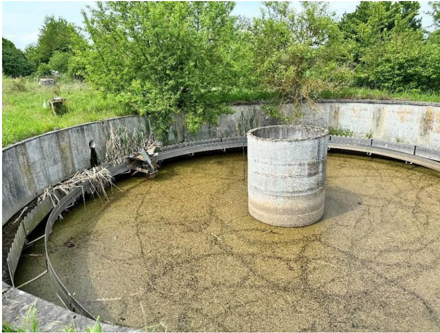
Abb. 26: Vorhandenes Klärbecken im Bereich des ehemaligen Kläranlagengeländes im Nordteil der Liegenschaft (Mai 2024)
