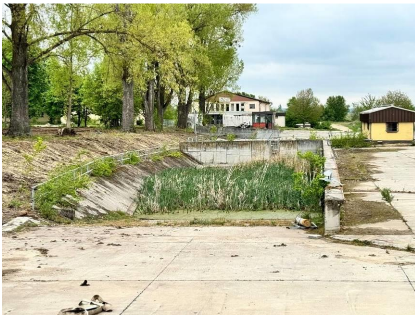
Abb. 28: Technisches Wasserbecken im mittleren Bereich der Liegenschaft (April 2024)
