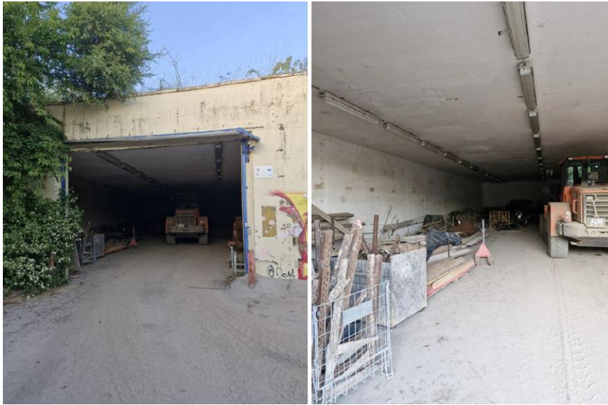
Abb. 37: Ansicht des nördlichen Bunkerbauwerkes (Mai 2024)
