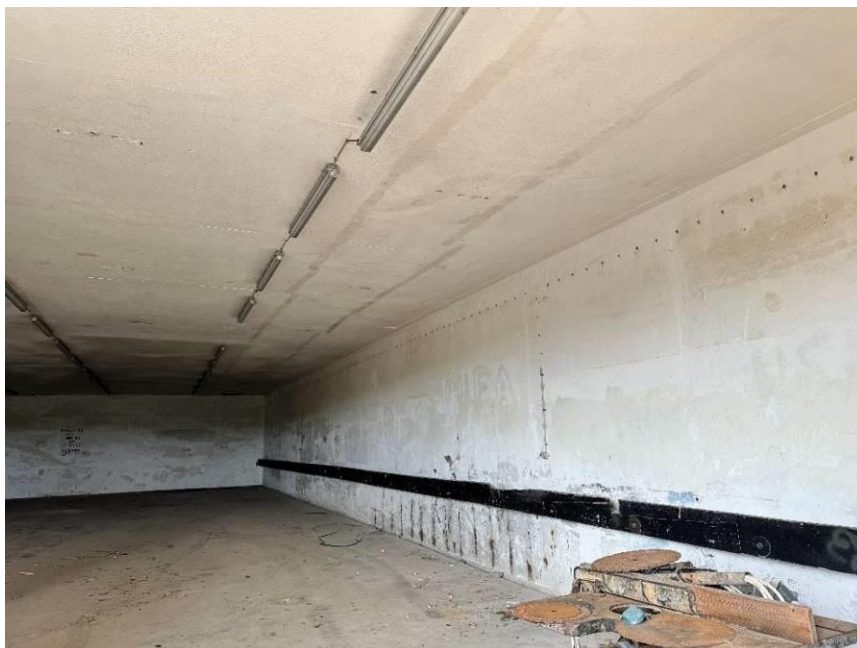
Abb. 36: Innenansicht des südwestlichen Bunkerbauwerkes (März 2024)
