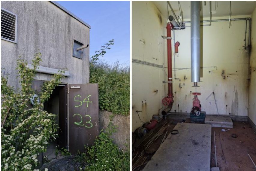
Abb. 38: Ansicht des mittleren Bauwerkes (Mai 2024)
