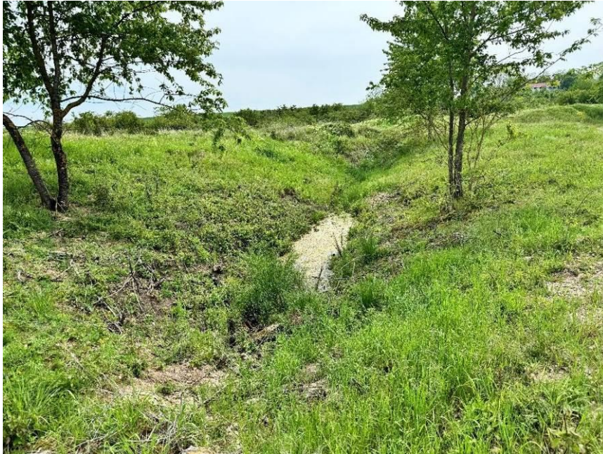
Abb. 22: Graben im nordöstlichen Bereich der Liegenschaft (Mai 2024)
