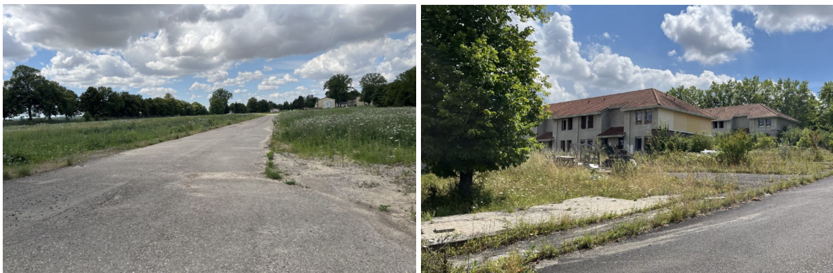
Abbildung 14: Bestandsinfrastruktur und -gebäude (1) (Quelle: Eigenes Foto)
