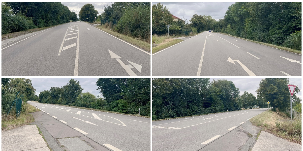
Abb. 17 KP 12, B 420 / Anschluss Mitte (AS2) im aktuellen Ausbauzustand
