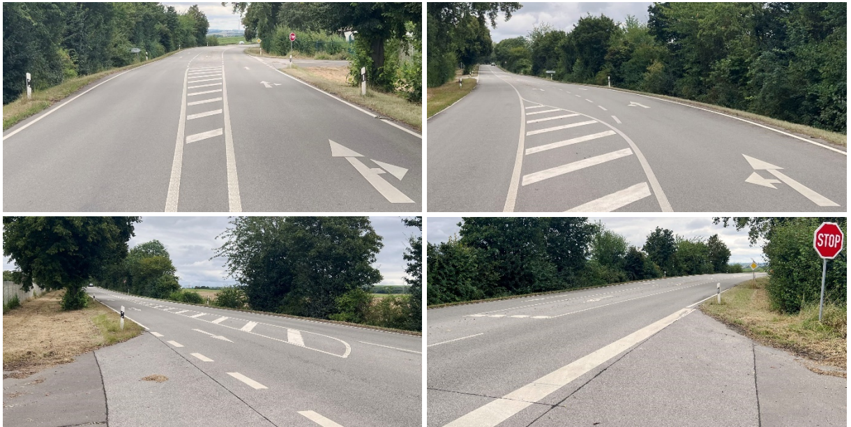
Abb. 16 KP 11, B 420 / Anschluss West (AS1) im aktuellen Ausbauzustand
