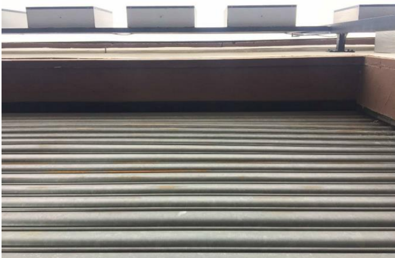
Abbildung 7: Öffnung oberhalb des Tores, potentiell Einschluflmöglichkeit in die Lagerhalle
