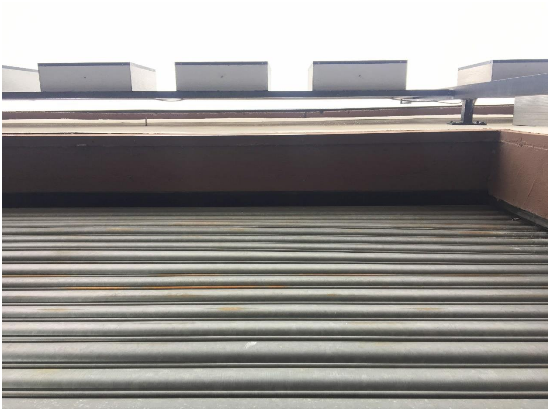
Abbildung 4: Die Öffnung oberhalb des Tores bietet Einschulpmöglichkeit in die Lagerhalle.
