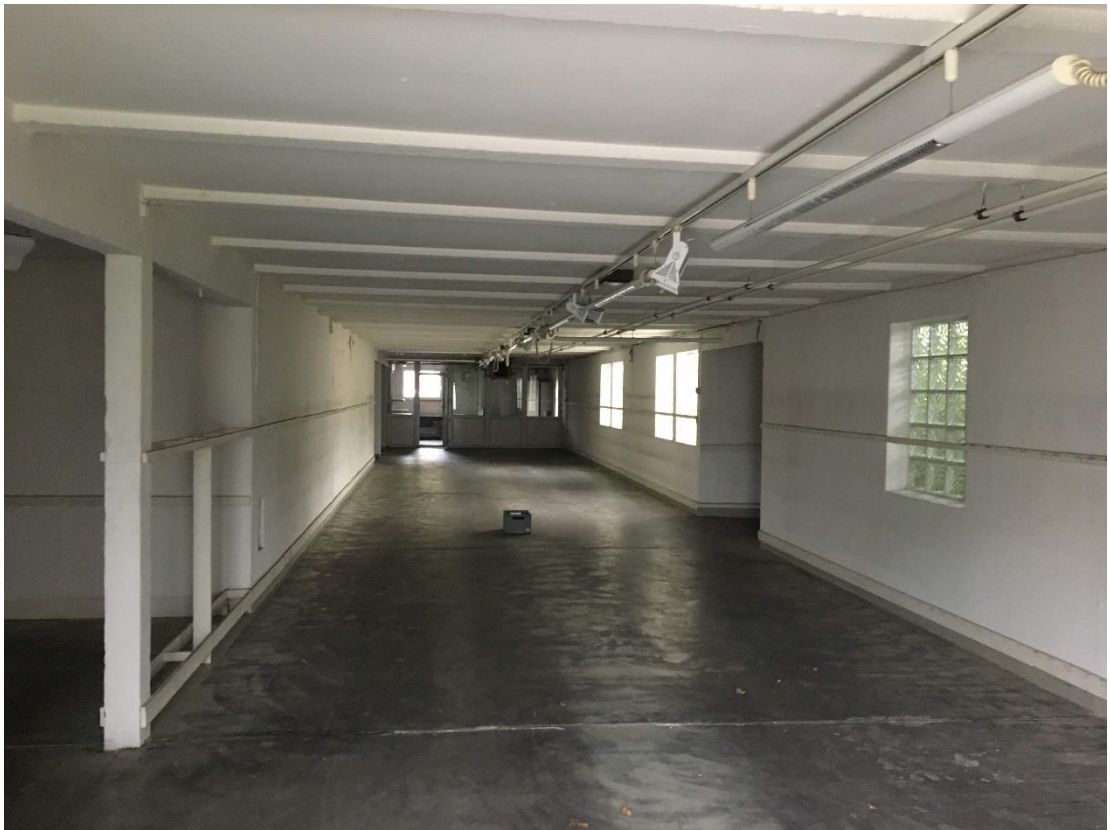
Abbildung 7: Ehemalige Verkaufsfläche. Bis auf die Öffnung oberhalb des Tores wies keines der Bestandsgebäude einsehbare Einschlußmöglichkeiten (bspw. durch Beschädigungen der Außenwände, Fenster etc.) auf. Alle Gebäude waren zum Zeitpunkt der Begehung frei von Tieren.
