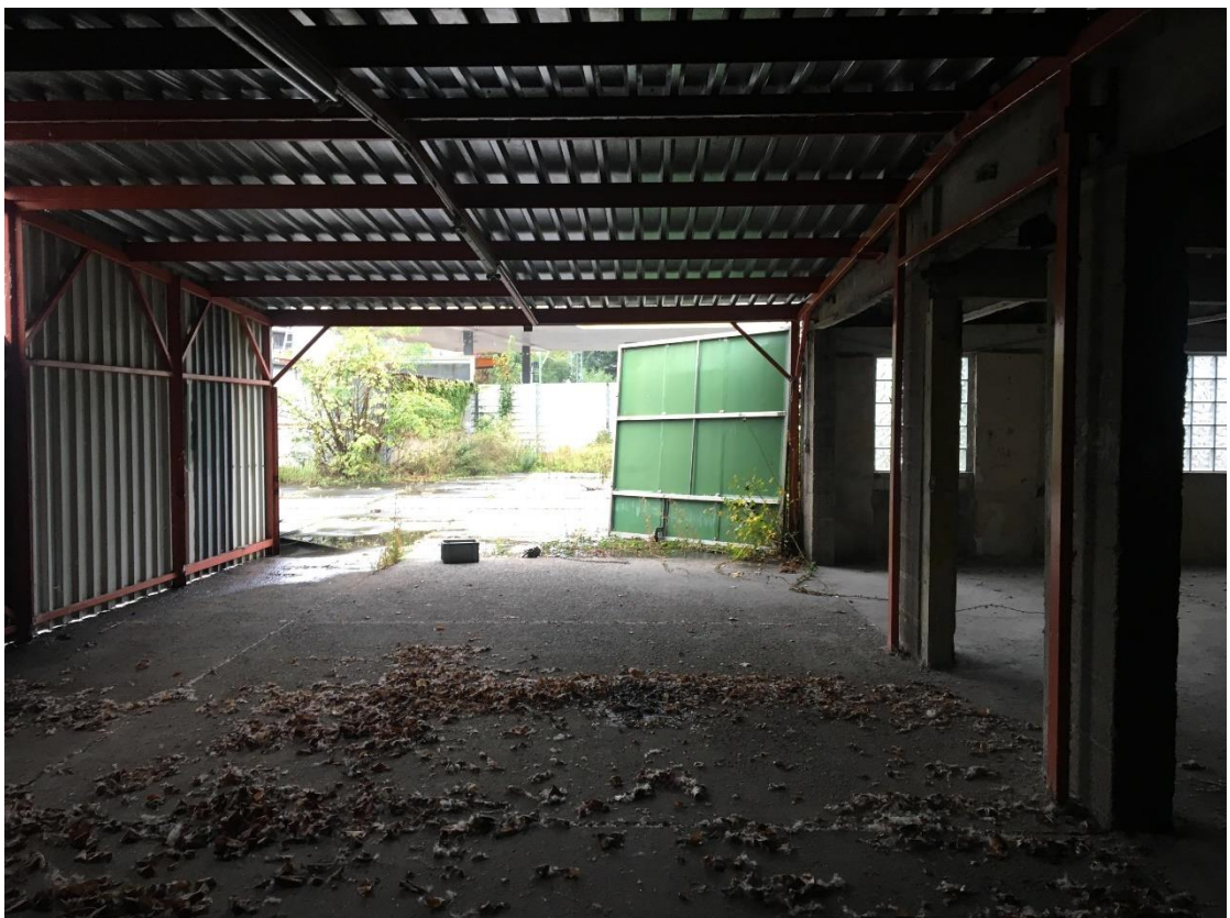
Abbildung 12: Eingangsbereich der Garage im Hinterhof.
