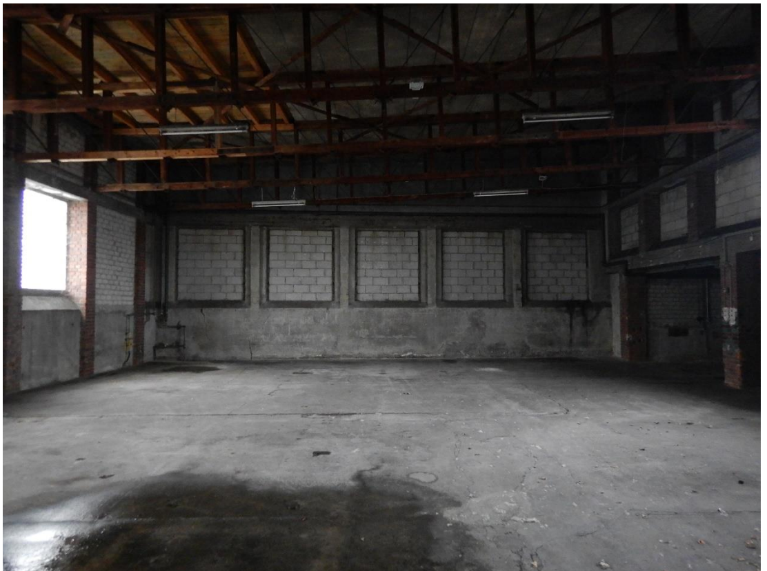
Abbildung 6: Lagerhalle von innen. Potentiell quartierbietende Strukturen werden derzeit nicht als Fortpflanzungs- oder Ruhestätte genutzt.
