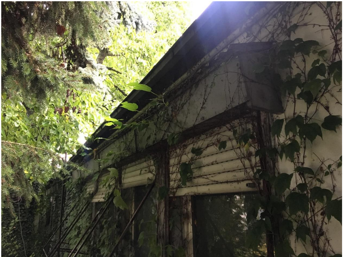
Abbildung 11: Vorhandene Rollladenkästen wurden zum Zeitpunkt der Begehung nicht als Fortpflanzungs- oder Ruhestätte genutzt.
