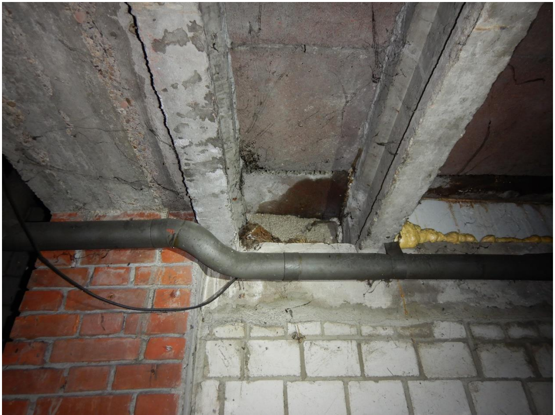
Abbildung 5: Ehemals genutztes Nistmaterial im hinteren Teil der Lagerhalle.
