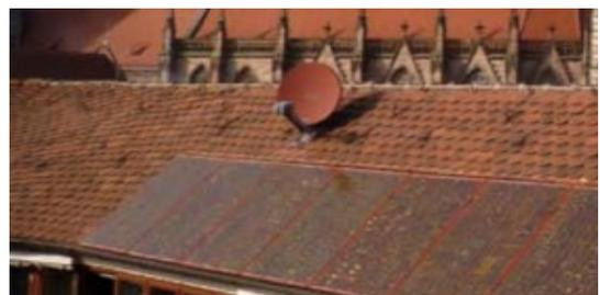
**Farblich dem Anbringungsort angepasster Parabolspiegel**
