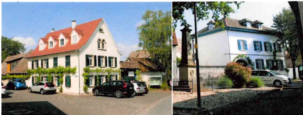
Abbildung: Gebäude mit giebelständiger Fassade Quelle: Eigene Fotografien
