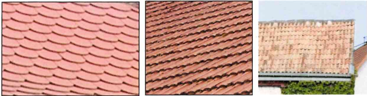
Abbildung: Beispiele typischer Dachmaterialien: Biberschwanz-, Doppelmuldenfalzziegel, rheinhessische Hohlpfanne Quelle: Eigene Fotografien
