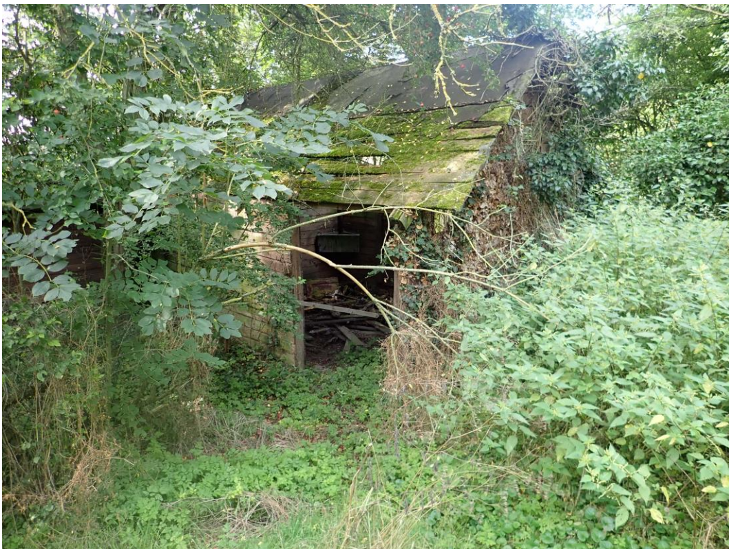
Bild 06: Im Südosten befinden sich mehrere ehemalige Viehställe aus Holz
