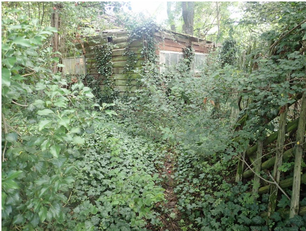
Bild 11: In dem Hang, der sich über die gesamte Fläche von Westen nach Osten erstreckt, befinden sich weitere Unterstände
